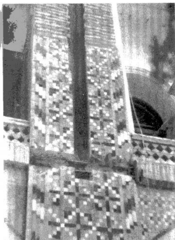
تصویر ۱۳ کلاف آهن برای تقویت سطح اتکای میل مهار در ستون باربر و همچنین در سقف طبقه زیرین.
