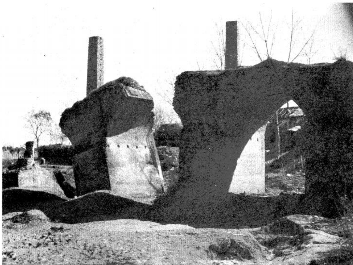
تصویر ۱ ساری، فرح آباد - پل رودخانه تنج، آسیب بر اثر سیل.
