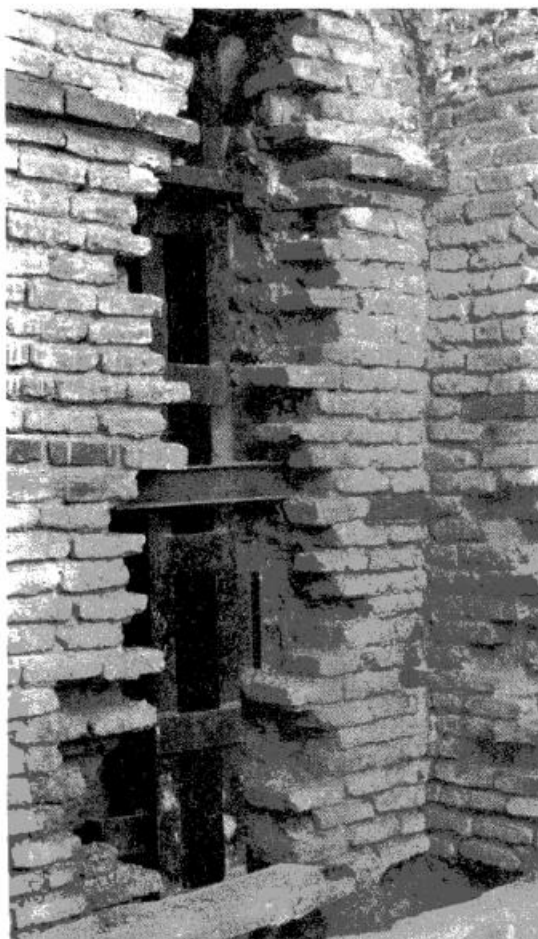
تصویر ۵ ارومیه - مسجد جامع، آهن‌کشی در دیوار شبستان.
