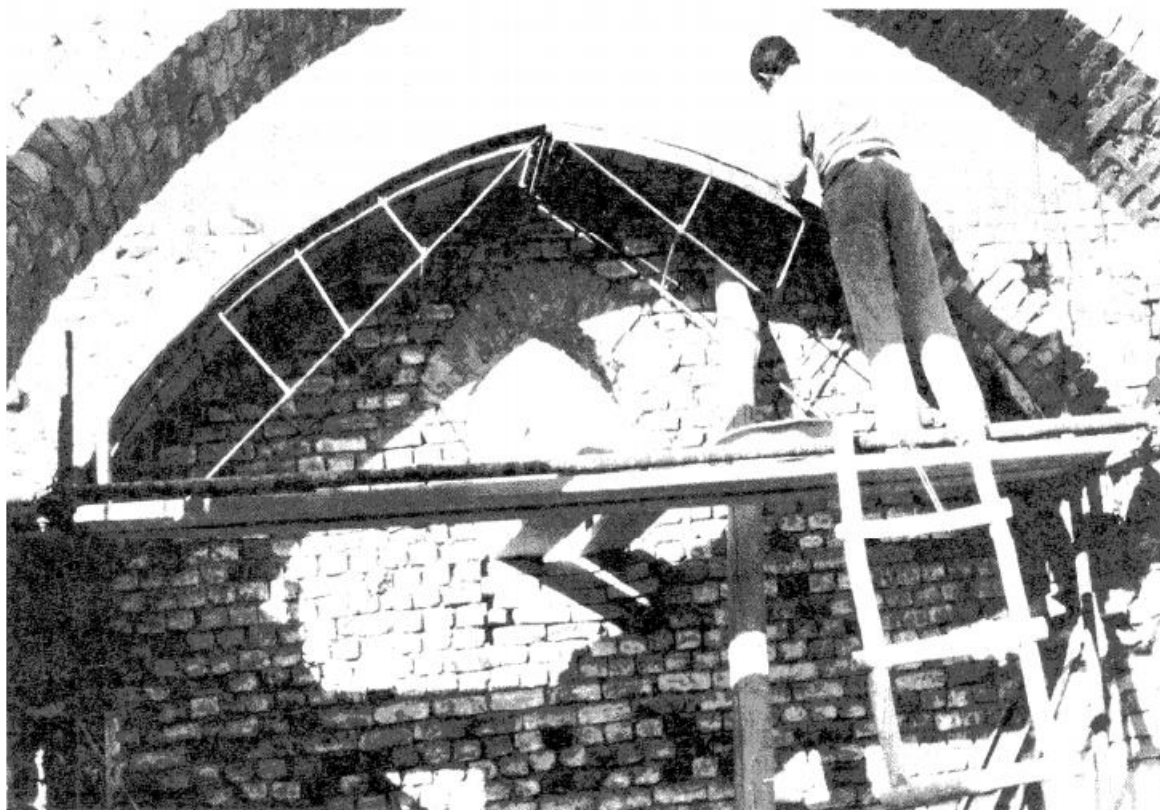
تصویر ۱ اشتهاورد - امامزاده، اجرای قوس رومی با استفاده از قالب دبد.
