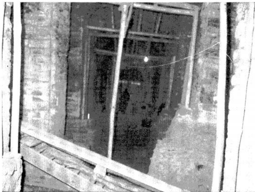
تصویر ۴ ارومیه - مسجد جامع، شمع‌بندی و عملیات رفع خطر.
