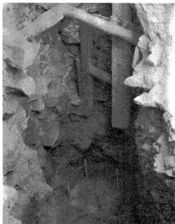
تصویر ۲ ارومیه - مسجد جامع، آهن‌کشی، پی‌سازی و صفحه‌گذاری پایه عمودی.
